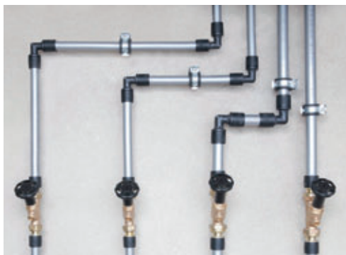
Распределитель холодной воды с RAUTITAN
